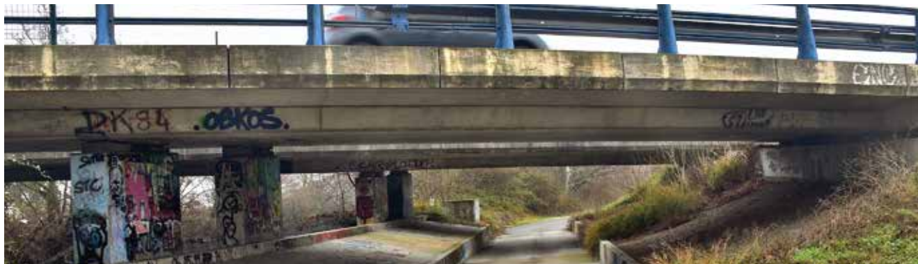
Passage sous voie, corridor écologique identifié le long de la Sorgue d'Entraigues-sur-la-Sorgue
