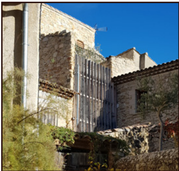
Brise-soleil sous forme de ventelles en bois verticales.
